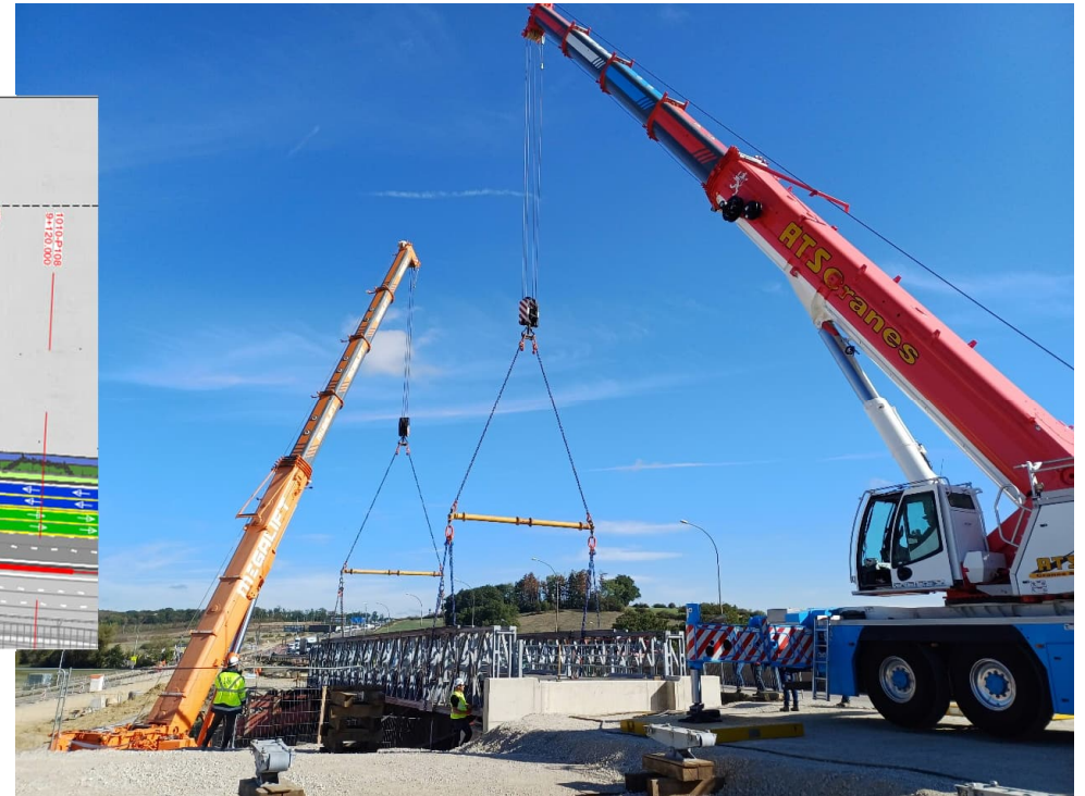
Mise en place de l'ouvrage provisoire à Livange
