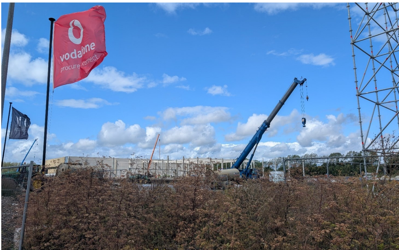
Abb. 10 : : Blick auf die Bauarbeiten zum Vodafone-Projekts (Quelle: LSC360 2025).
