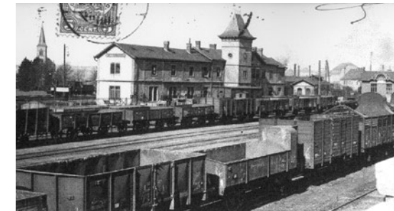
Vue sur le bâtiment de la gare de Bettemburg / Blick auf das Bahnhofsgebäude Bettemburg. © Archives Commune de Bettembourg
