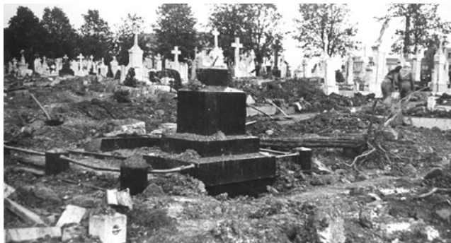
Tombes détruites et endommagées dans le cimetière de Bettembourg après l'attaque aérienne du 11 mai. / Zerstörte und beschädigte Gräber im Bettemburger Friedhof nach dem Luftangriff vom 11. Mai. © Archives Commune de Bettembourg.
