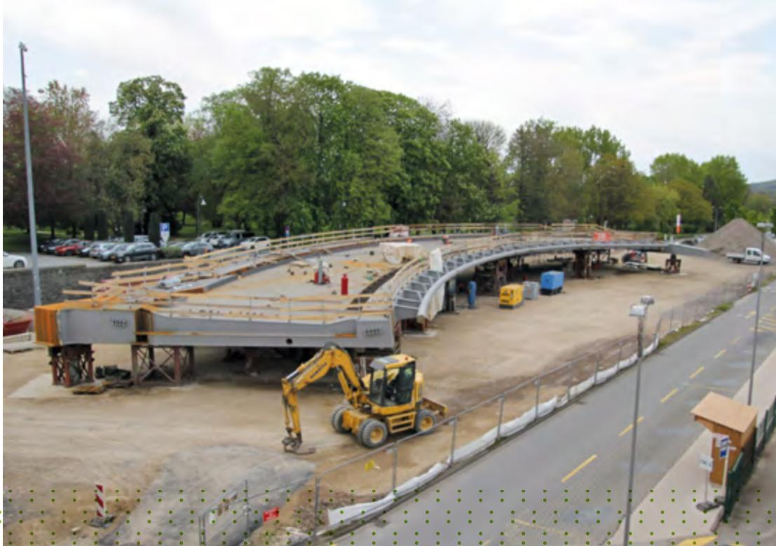
Le tablier du pont est en cours d'assemblage sur le parking de la gare.
