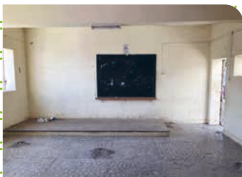
Salle de classe avant la rénovation.
